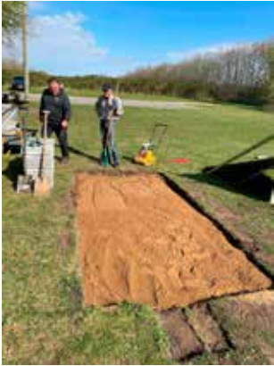
Der skal fliser under springbrættet
